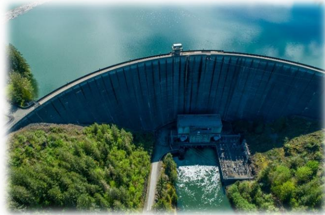
نمای هوایی دیوار بتنی سد دریاچه آلدردر
